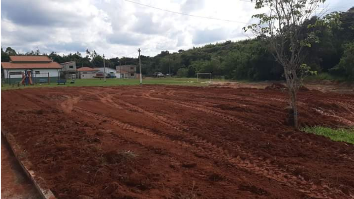
Figura 2: Terreno da Nova Creche – Movimentação de Terra
